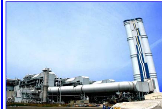
川崎火力発電所1号系列(MACC)
